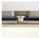
Pilzkopfverriegelung Sie verhindert das Aushebeln des Flügels.
